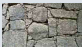
打ち込み接ぎ 石をある程度加工して、隙間には間詰め石を打ち込んでいる。丸亀城の主な石垣は、この積み方による。
