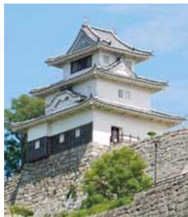
丸亀城天守（重要文化財） 通し柱を使わず各階に柱を立てて、上に行くほど狭くなる割合を大きくし、下から見上げると大きく見えるように工夫された天守。
