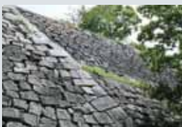
石垣の上にさらに築かれた石垣。重みにより崩れ、そこから破壊が始まるのを防ぐために支えの石垣が築かれている。
