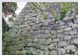
切り込み接ぎ 加工した石を隙間無く積み上げたもの。大手門などの大切な場所で見られる。「接ぎ」とはつなぎ合わせるという意味。
