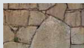
切り込み接ぎ 加工した石を隙間無く積み上げたもの。大手門などの大切な場所で見られる。「接ぎ」とはつなぎ合わせるという意味。
