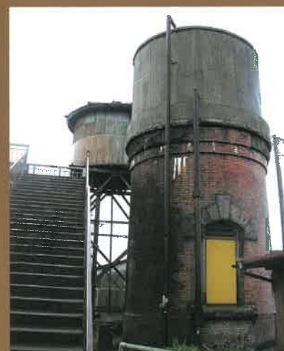
給水塔（竣工は大正2年。鉄筋コンクリートの貯水槽は、昭和25年改築されたもの。）
