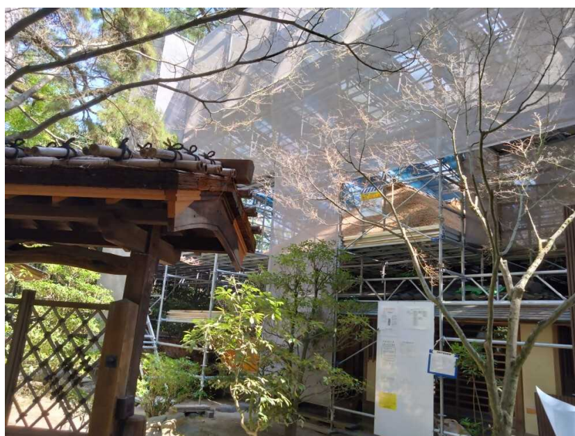
(3月23日現在の日暮亭屋根改修工事の様子)
